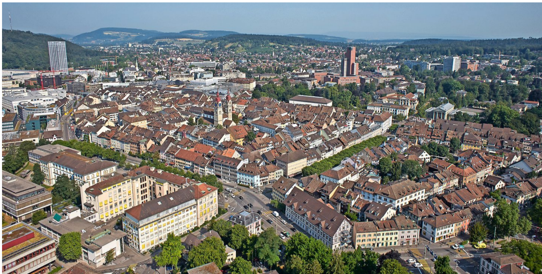
Winterthur (hier eine Luftaufnahme von 2015) wird immer dichter und wächst in die Höhe. Welche Regeln braucht dieses Wachstum? Foto: Emanuel Ammon
