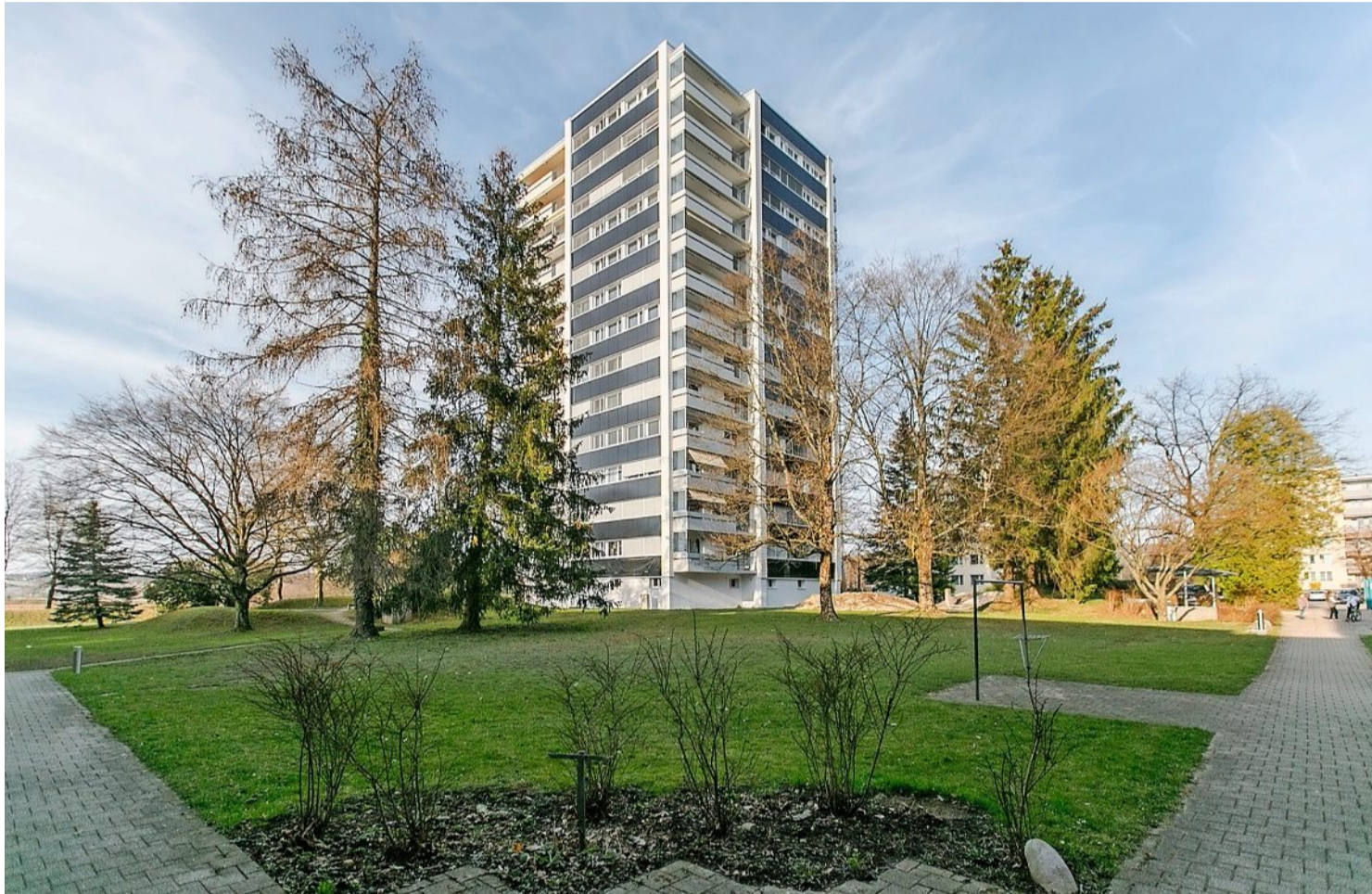
In den Brüstungen unter den lang gezogenen Fensterbändern sind die Solarpanels am Hochhaus montiert. Foto: PD
