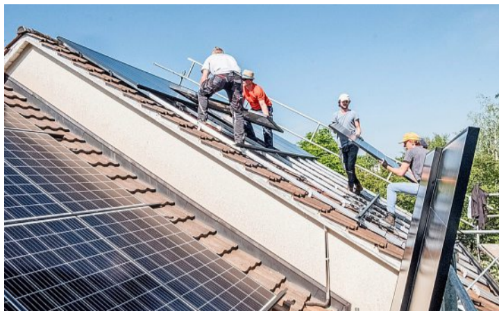
Laien installieren auf dem Dach eines Einfamilienhauses in Hettlingen unter Anleitung des Bauleiters (oranges T-Shirt) eine Solaranlage. Foto: PD
